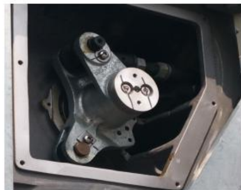
35KV SF6 开关传感器安装
